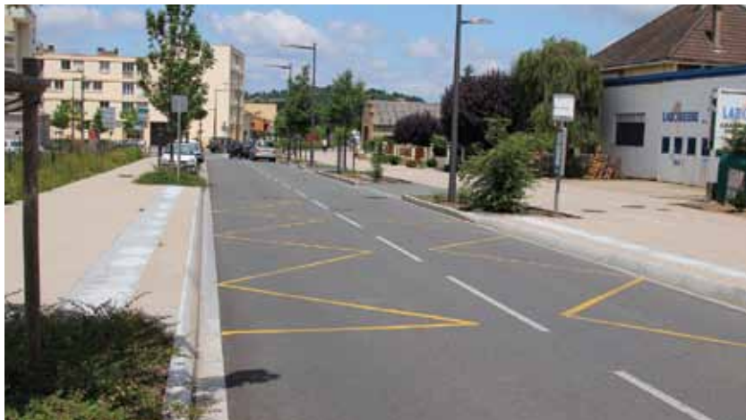
LES ARRÊTS DE BUS SONT PEU À PEU MIS AUX NORMES D'ACCESSIBILITÉ : BATEAUX, BANDES PODOTACTILES
