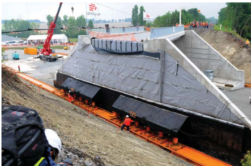
SUR LE CHANTIER DE LA BRETELLE AUTOROUTIÈRE, LE NOUVEAU PONT-RAIL CONSTRUIT ACCUEILLERA LE TRAFIC FERROVIAIRE ENTRE GANNAT ET SAINT-GERMAIN-DES-FOSSÉS
